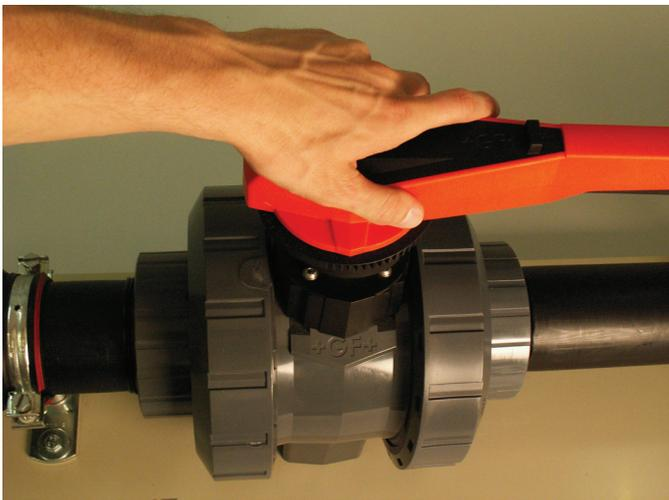
6 Montieren Sie den Handhebel auf das Gehäuse.
